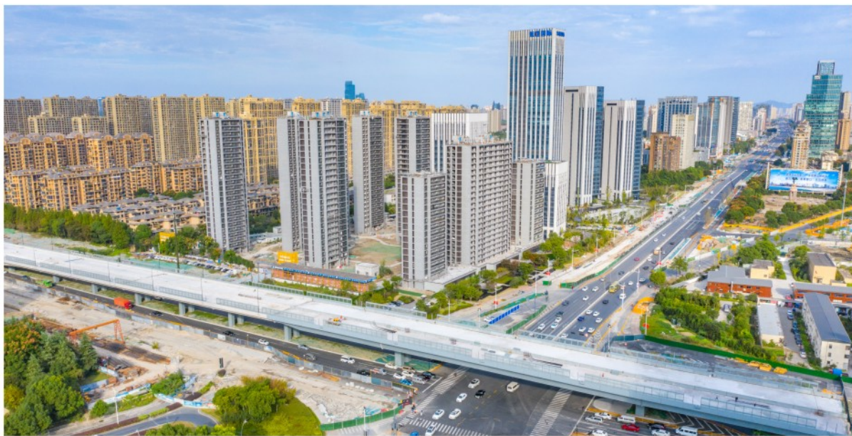
▲ 风情大道快速路（机场路—金城路）主体完工
