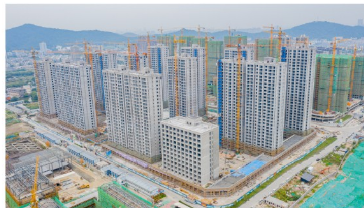
▲ 戚家池联丰安置房项目主体结顶
