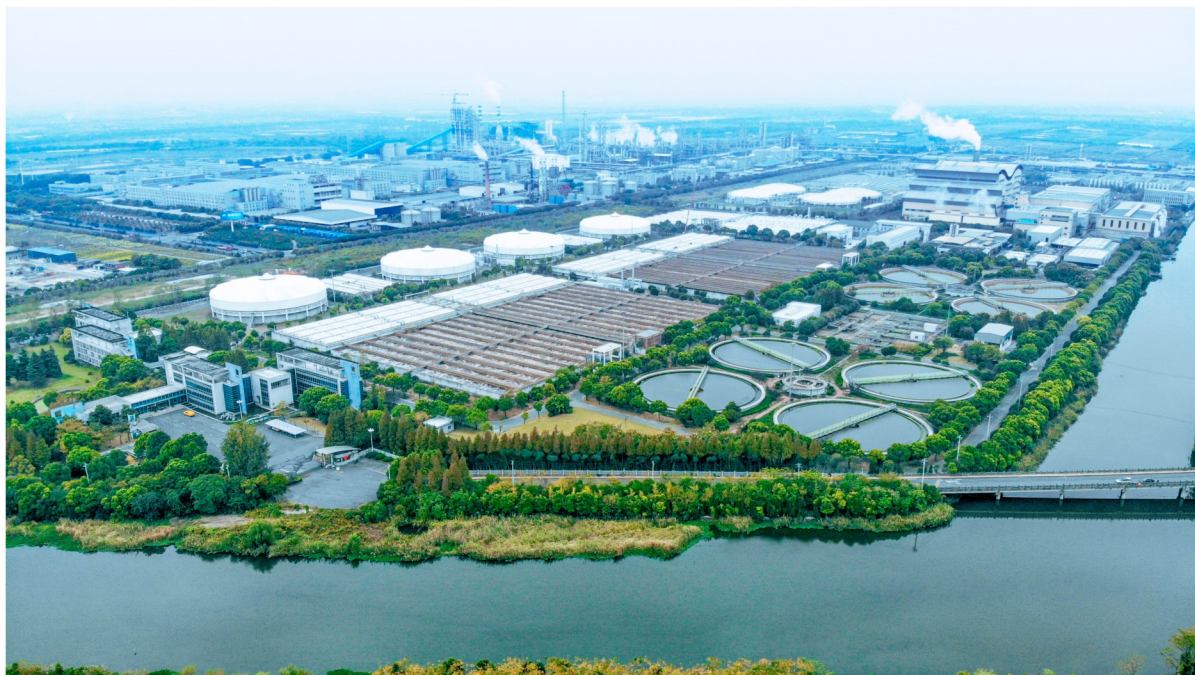
▲ 临江污水处理厂
