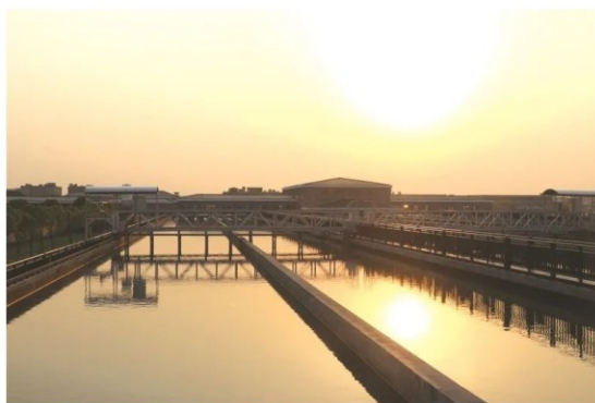
▲ 江东水厂二期改扩建工程
