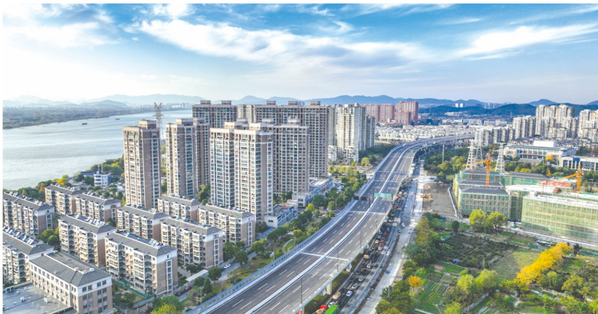
▲ 时代大道改建工程
