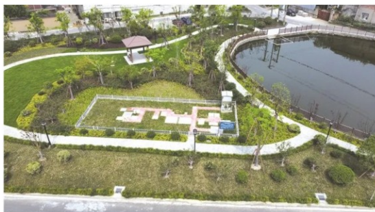
▲ 农村生活污水处理设施全覆盖工程
