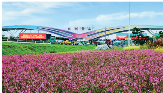
▲ 机场主线收费站
