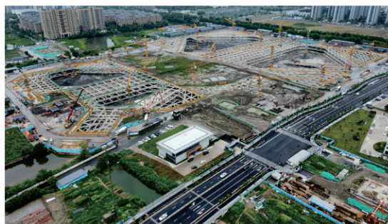
▲ 浙大二院萧山院区完成桩基工程，正在开展地下室结构施工
